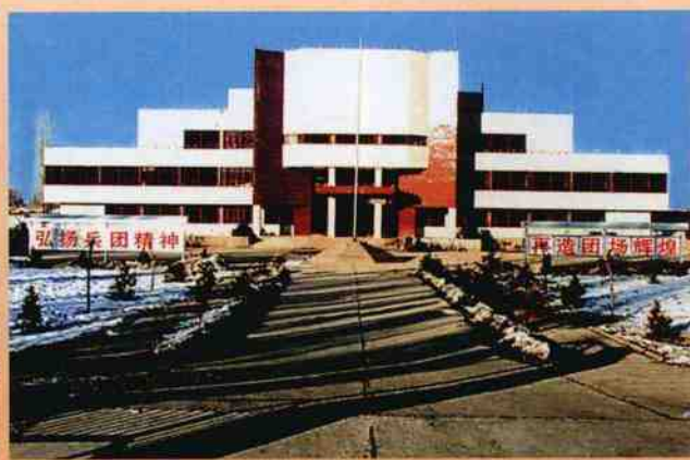
机关办公大楼
