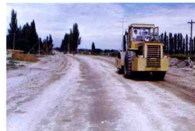
修筑团场柏油路
