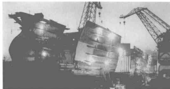
“走中国自己工业发展的道路”。上海船厂在三千吨级的船台上造出了万吨级的远洋货轮。图为该厂工人在“夜战船台”。
