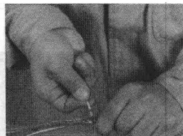
将第一组的 2 根芯线按顺时针方向 缠绕 2 圈后向右扳直
