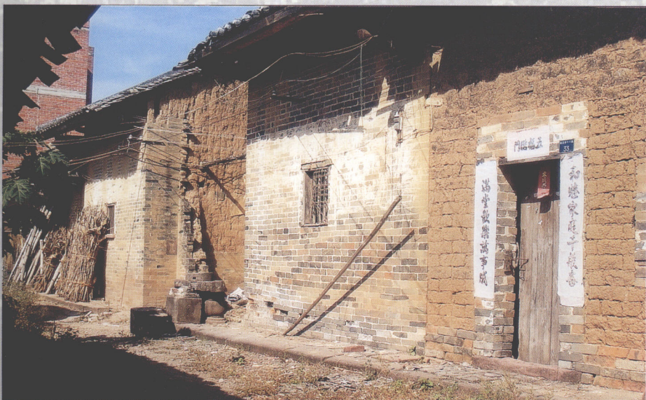
图1-18 贵县大狮岭城原地主大屋旧址。
