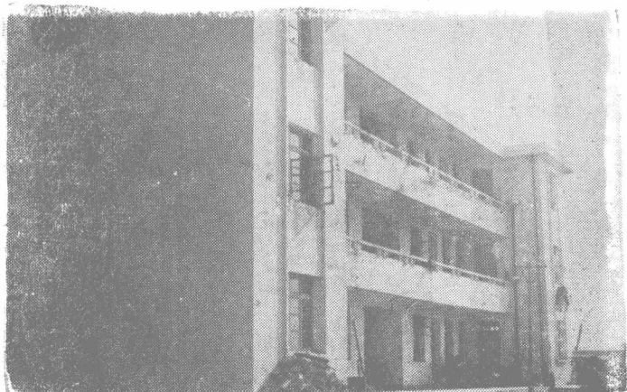
鄞县公路段 横涨道班房
