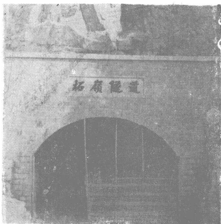
正在掘进中的柘岭隧道入口处
