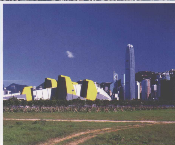
九龙通风塔，香港 位于黄金地段，从通道内排出了来自火车、设备机房和乘客的累计热量，并在热交换制冷系统中使用海水。
