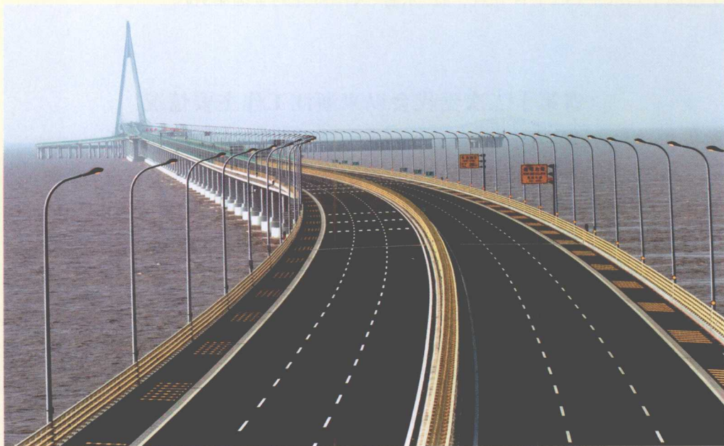
杭州湾跨海大桥(许萃摄)
