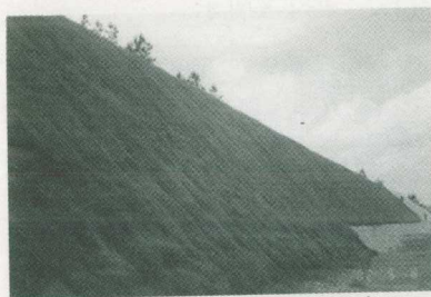
图1-6 高速公路护坡草坪
