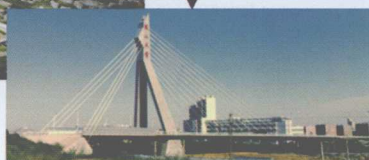
燕山大学立交桥 横跨205国道和京哈铁路
