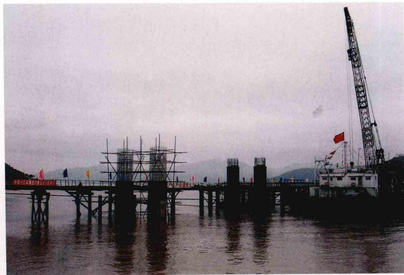
三门口大桥南门桥墩正浇灌中 (何幼松摄)
