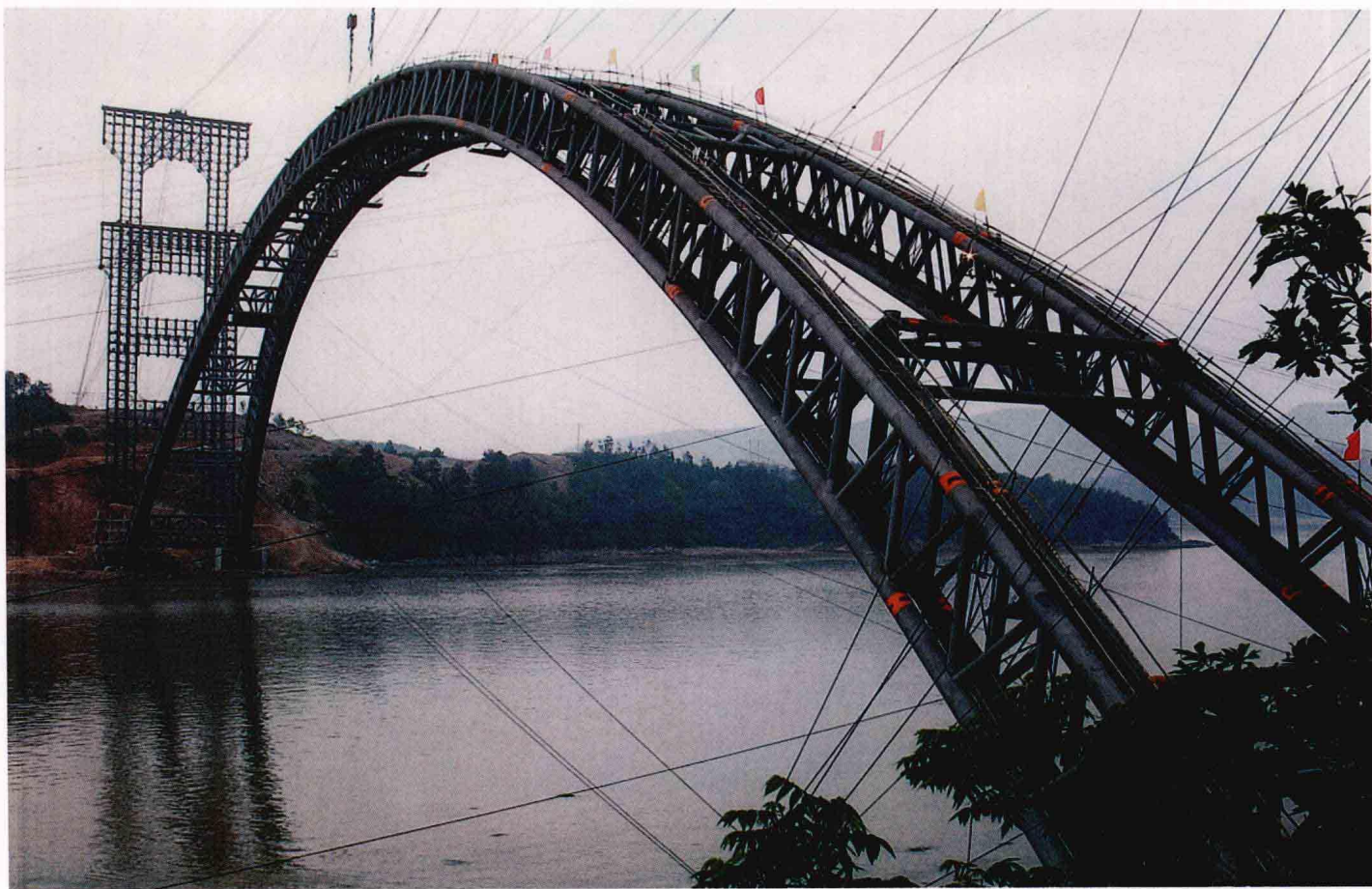
三门口大桥北门桥合龙 (何幼松摄)
