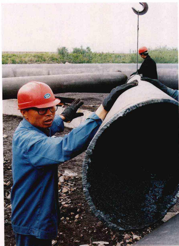
三门口大桥中桥钢管起吊焊接 (何幼松摄)
