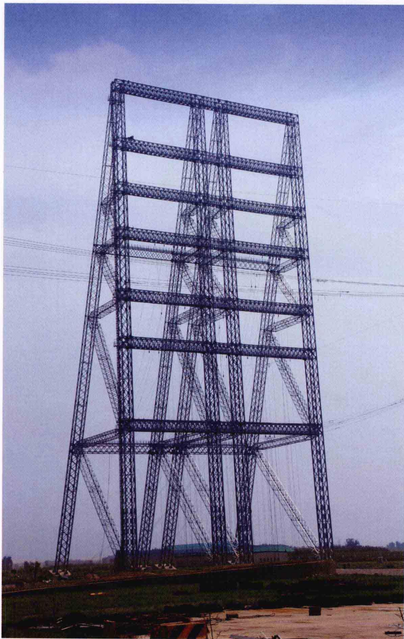
特高压杆塔试验基地纵向加荷塔。
