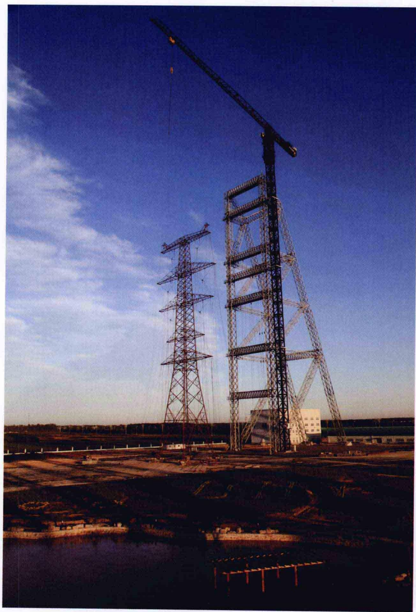
特高压杆塔试验基地纵向反向加荷塔。
