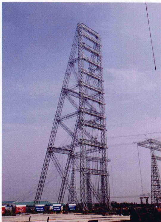
特高压杆塔试验基地 横向加荷塔。
