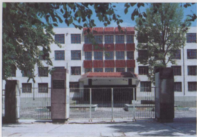
中共都兰县委、都兰县人大常委会、都兰县人民政府办公楼
