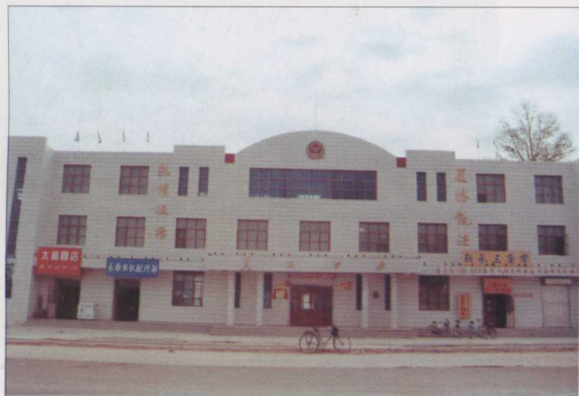
都兰县公安局办公楼
