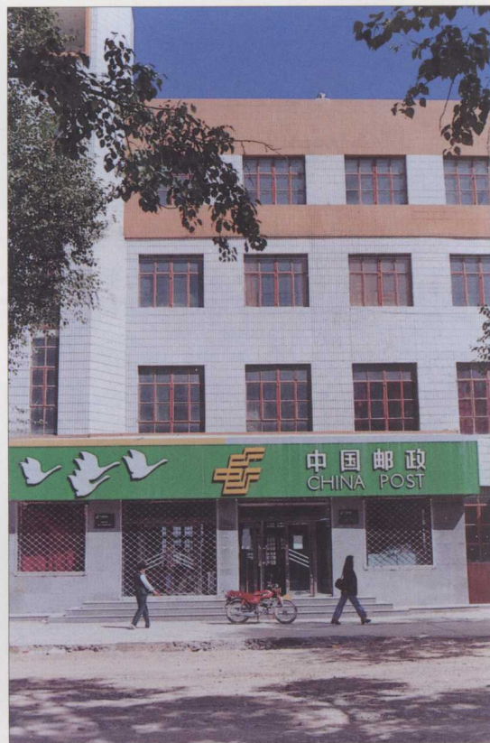
都兰县邮电局办公楼
