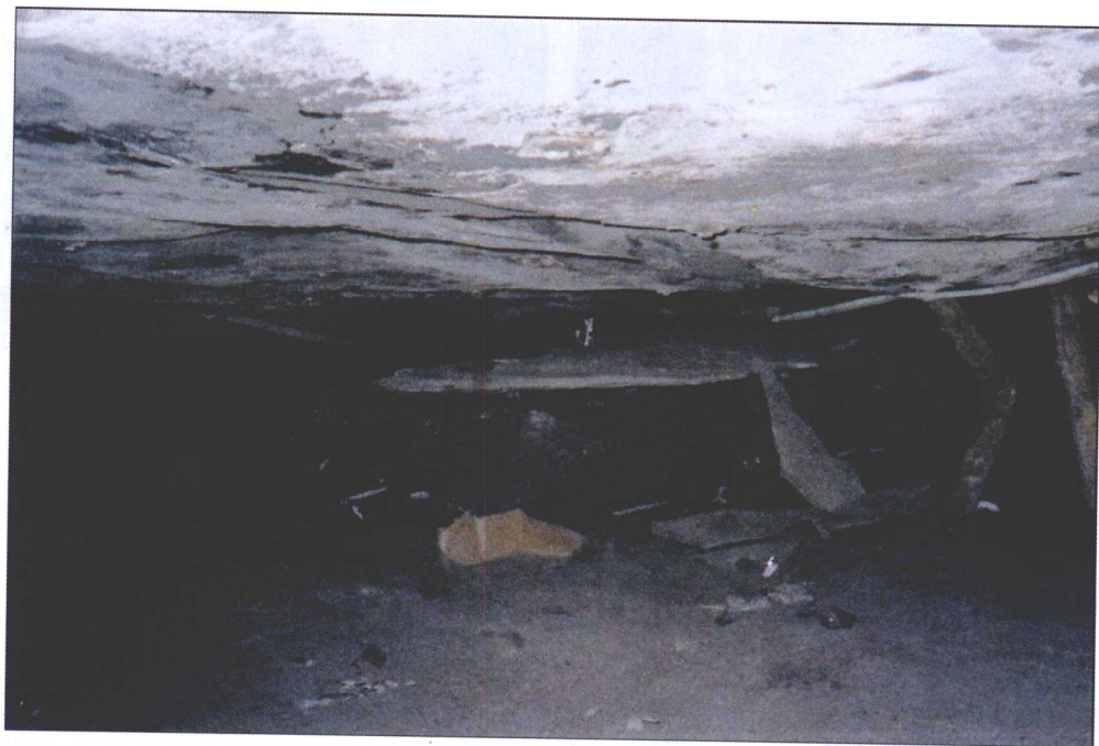
图 1-2-4 从位置 8(见图 1-2-2)处向内看残留煤柱
