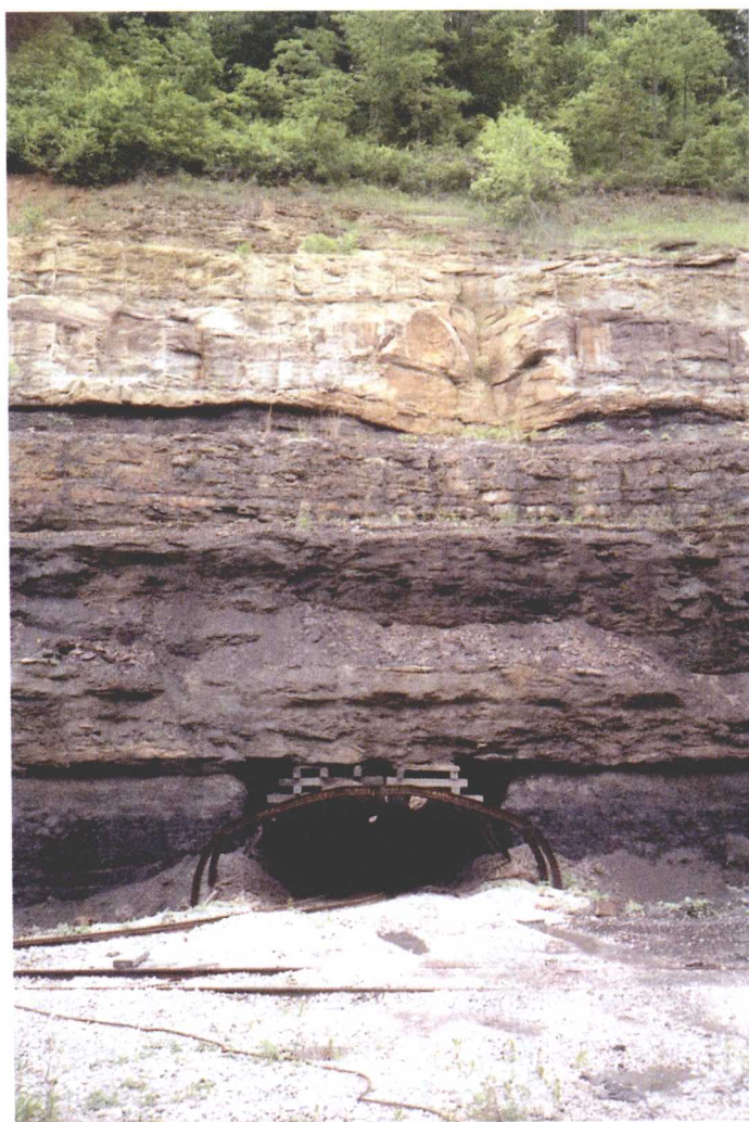
图 1-2-1 案例 1.1 中矿井入口处的边坡
