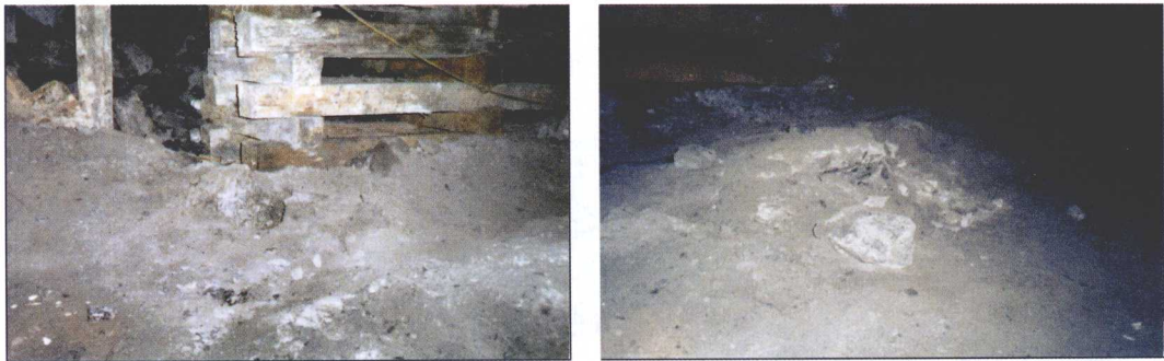
图 1-2-6 位置 7(见图 1-2-2)处沿着木垛边缘的底鼓
