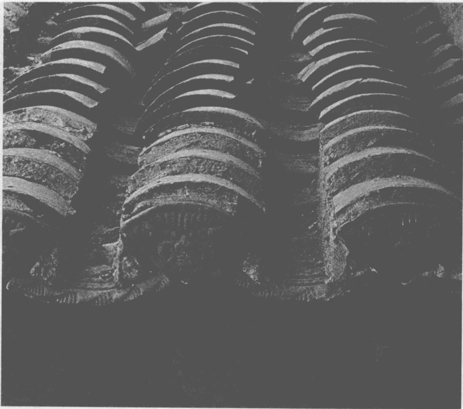
在房顶铺设板瓦和筒瓦，在屋檐处安置瓦当
