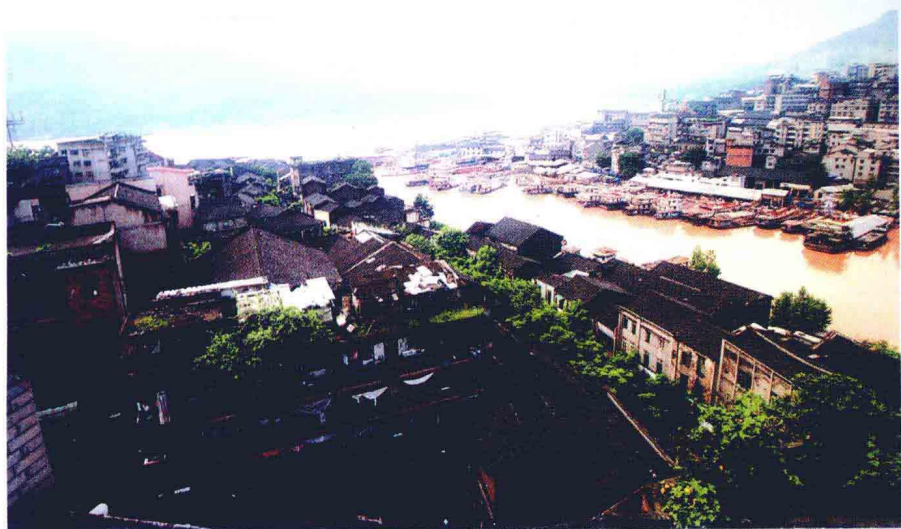
远眺环城路(2003年6月三峡工程二期水位淹没)
