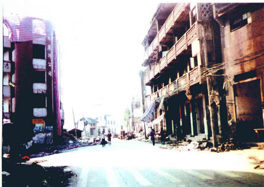
胜利路飞川大楼路段(2003年6月三峡工程二期水位淹没)
