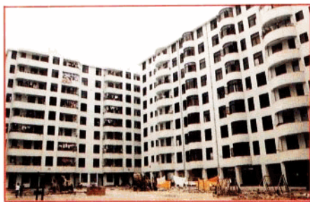
公司监理施工的海口市九中教职工住宅楼
