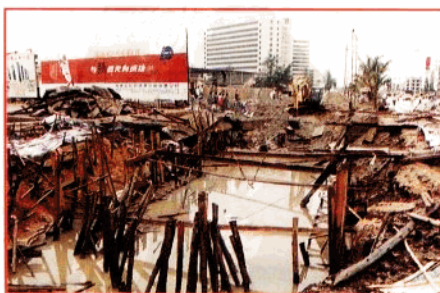
公司监理施工的海甸岛污水干道工程
