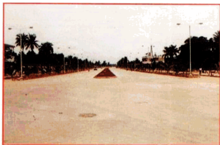
公司监理施工的滨海大道西延线(二期工程)
