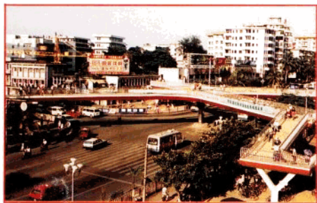
公司监理施工的人行桥7座(分别位于海口市海府路、文明东路、龙华路、大同路等交通要道),并能监理公路桥
