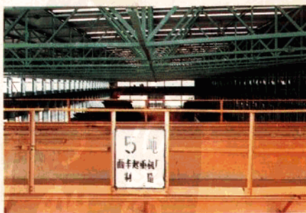
海南最大跨度(31.5m)吊车安装调试
