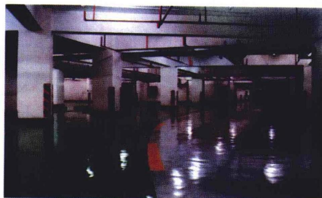
2001年4月 联合广场地下车库 KC-EC-140环氧砂浆及厚膜地板
