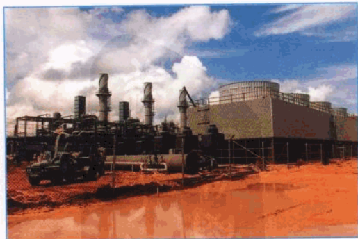
建设中的大型发电厂——清澜电厂
