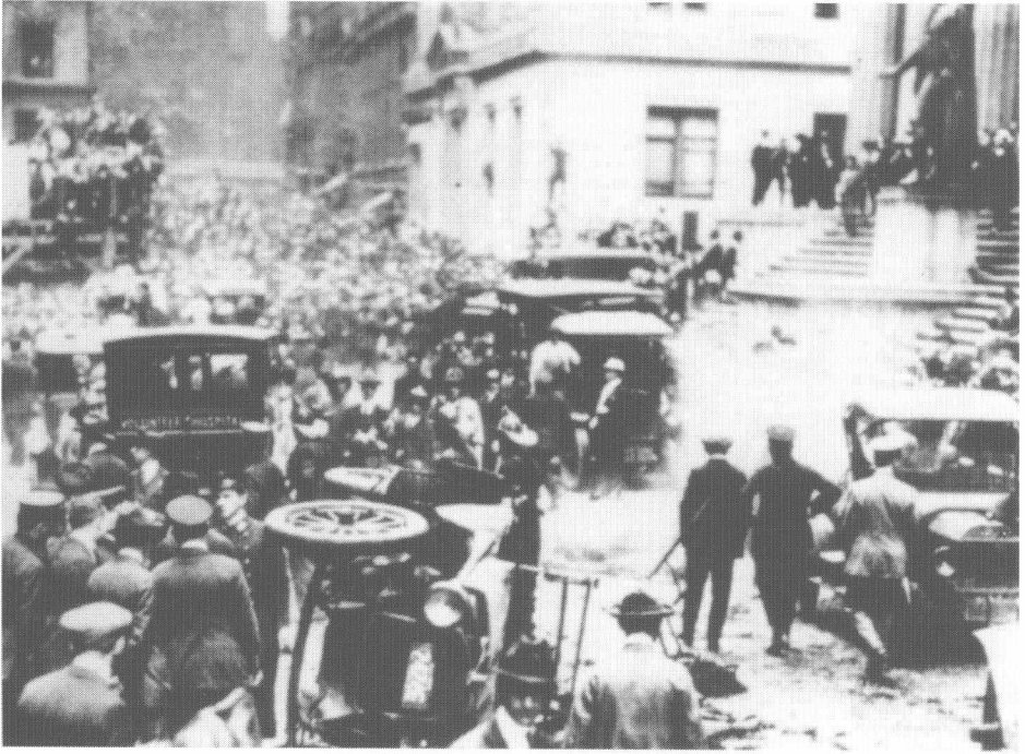
34. 1920年9月，摩根公司门外发生大爆炸，炸死两名职员，炸坏了大楼北面外墙。
