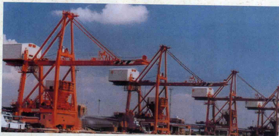
广州港新沙港泊位工程
