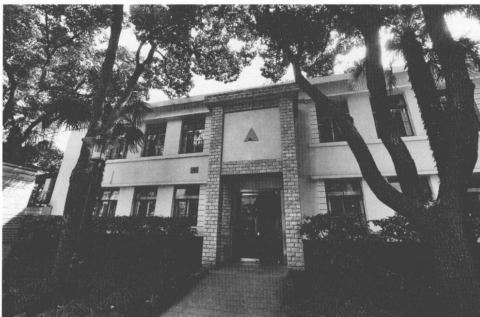
▲ 噪音室所在楼房的外观，噪音室“套”在里面
