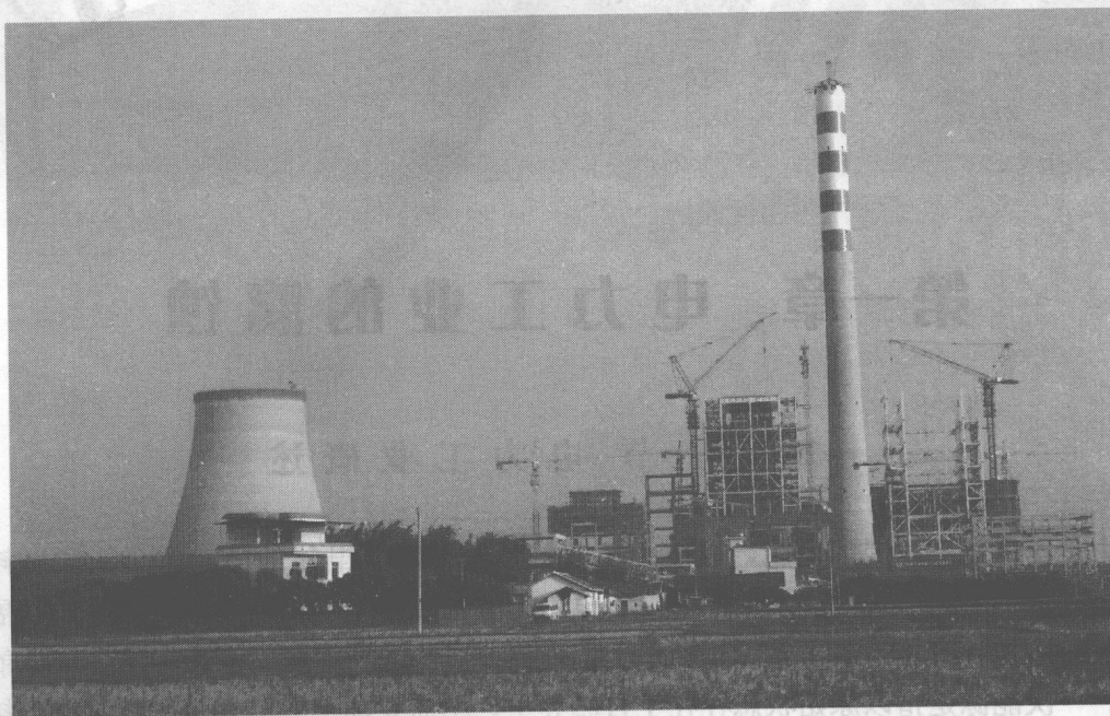
图 1-1 建设中的火力发电厂
