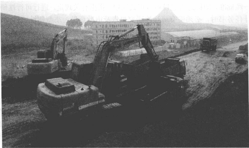
图 1.4 土方工程施工
