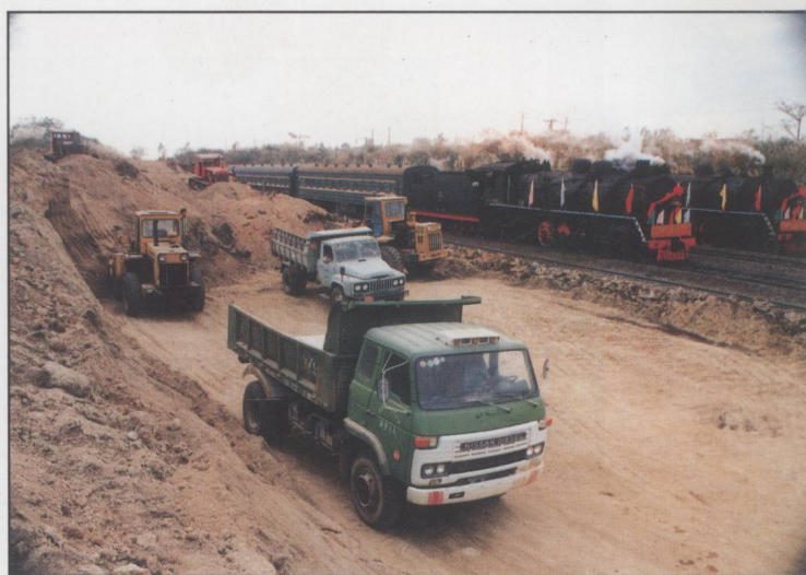
第一条海上铁路“通道” 国务院批准建设的琼州海峡铁路通道工程已经分段动工, 图为海南西环铁路扩建工程叉河至海口路段于1993年破土动工。(蒙传雄 摄)
