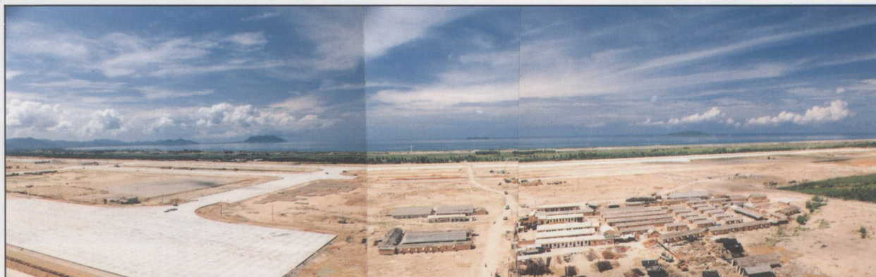
第一个国际机场 在建的三亚凤凰国际机场, 一期工程按旅客年吞吐量150万人次和波音747—200型飞机全载起降要求设计, 将于今年7月1日正式通航。建成后将是海南第一、我国南方第二大国际机场。
