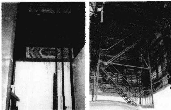
图1-3 消防设施设置与历史建筑测绘
