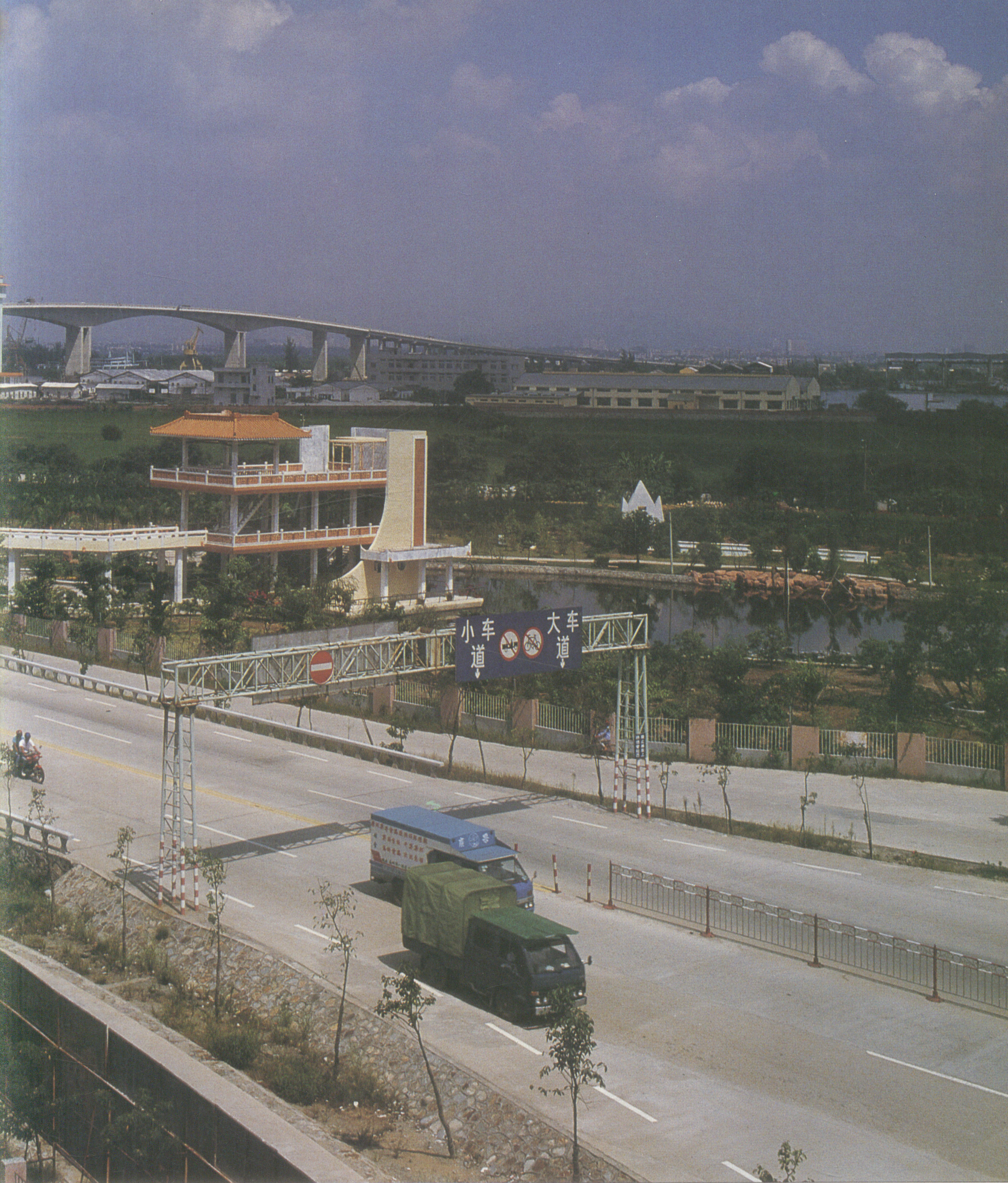
自80年代以来,广东通过各种形式筹集资金逾百亿元,建成公路桥梁4000余座,使全省10条主干线公路除海湾外实现了无渡口通车。广东也因此获得“中国第一桥乡”、“桥的博物馆”之美誉。图为被中外专家称为“亚洲第一桥”的番禺洛溪大桥,桥长近两公里,跨度180米,高40米。
