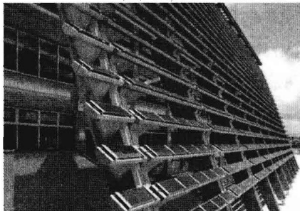
(d) 装有太阳能电池板的南侧遮阳格栅
