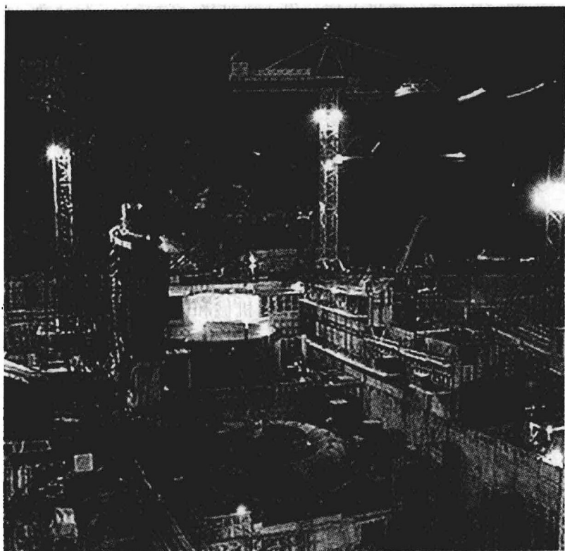
图 1-4 萨扬舒申斯克水电站的机组安装
