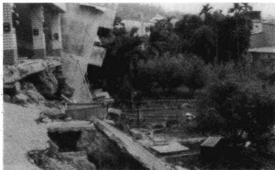
图 1.12 地基隆起导致建筑物破坏
