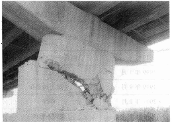
图 1.6 桥墩斜裂缝
