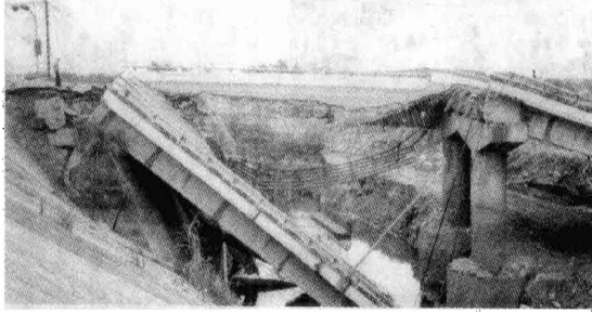
图 1.7 桥梁滑落
