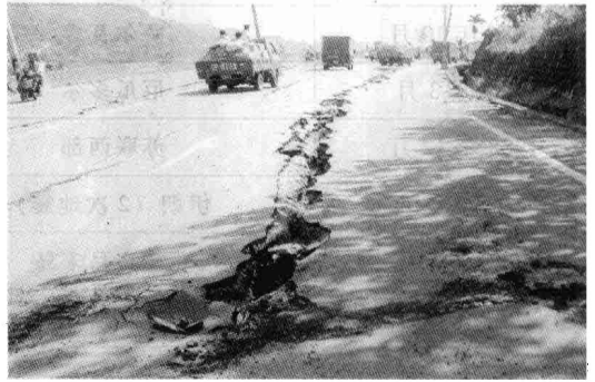
图 1.4 道路裂缝
