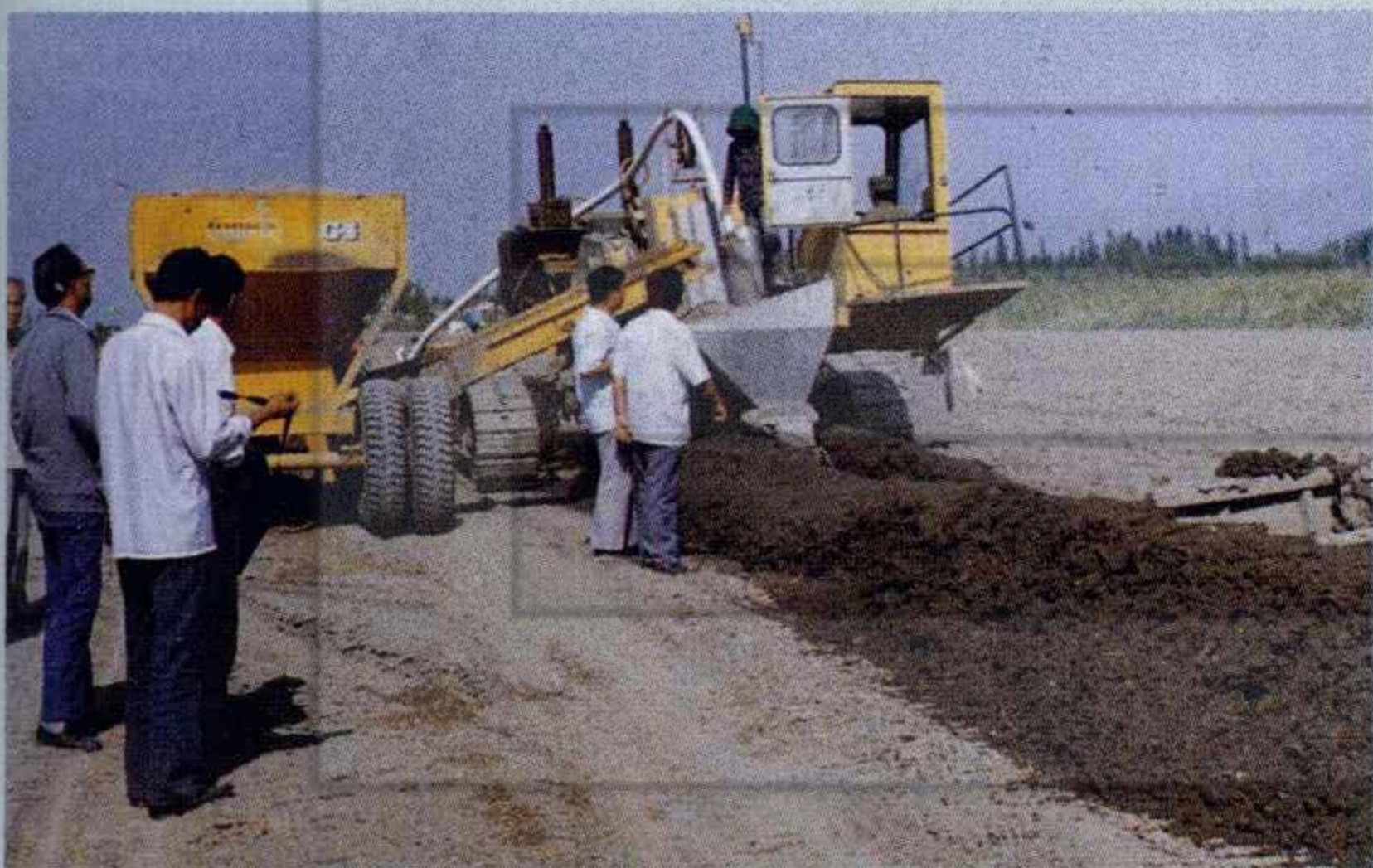
二十九团暗管排水工程施工
