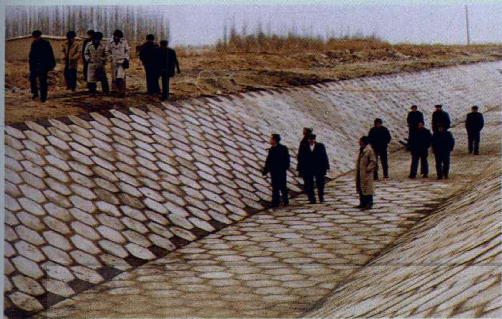
十八团大渠洪毁工程验收
