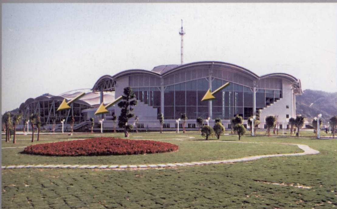
● 汕头游泳跳水馆 (▲ 为采用金刚产单片铯钾防火玻璃)
