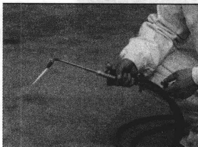
图 2-1 气焊的操作方法
