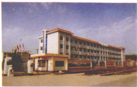
宛西制药厂办公楼
