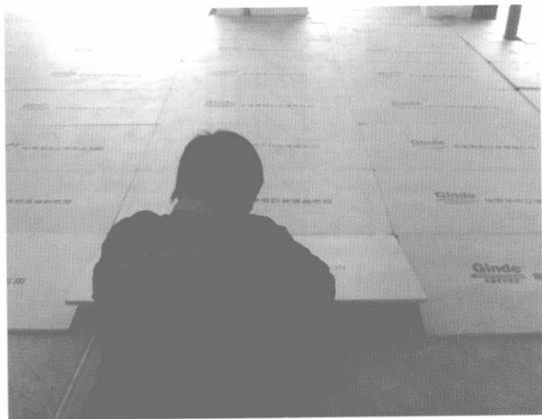
图1-7 | 铺设挤塑板
