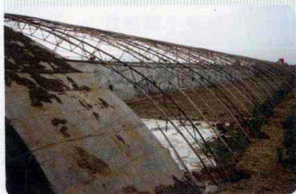
彩图2-1 寿光Ⅳ型冬暖大棚结构
