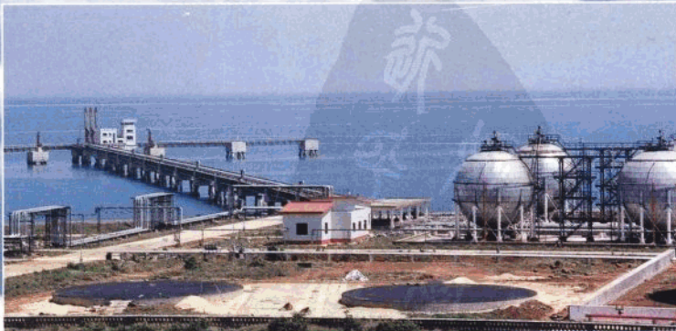
公司兴建的油气码头。
