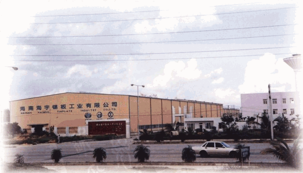
公司与韩国大宇、东洋锡板株式会社合资建设的海宇镀锡薄板厂全貌。
