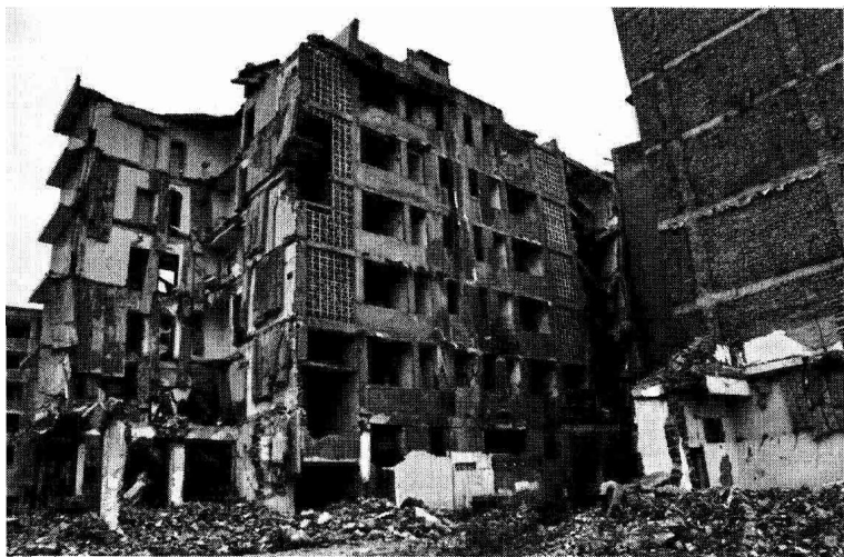
都江堰震坏的房屋
