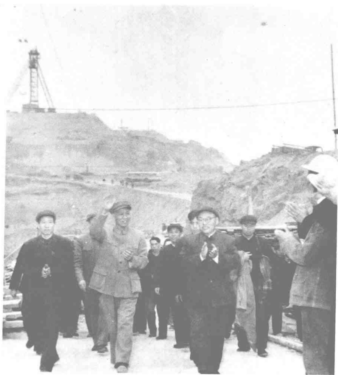
刘少奇同志视察三门峡工地
