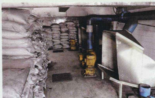
彩图 6-27 粉末活性炭工艺及炭库,实现了应急保障和深度水处理
