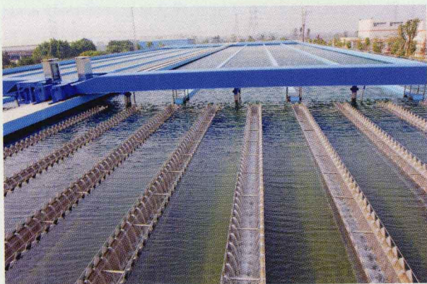
彩图 6-17 新建 B 厂 10 万 \text{m}^3/\text{d} 的平流沉淀池,稳定流出的是清澈的待滤水
