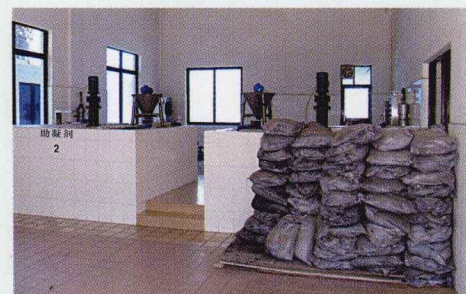
彩图 6-11 为强化净水,设置助凝剂投加系统。为应对突发性水源污染事故,储备粉末活性炭
