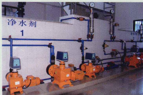
彩图 6-7 准确定量的净水剂投加,是水处理的重要一环
