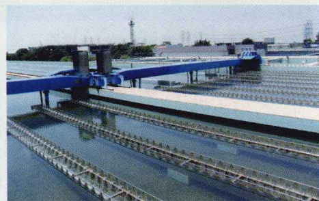
彩图 6-10 在水处理效果可靠的平流沉淀池集水区加装斜管,使沉淀池出水(待滤水)控制在 2 度以内,成为优质供水的重要保证
