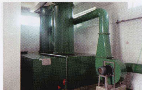
彩图 6-39 漏氯吸收设备,也得布置在“洁净室”
