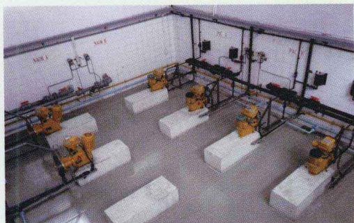
彩图 6-29 聚合铝(PAC)、碱剂投加,常规的药剂投加工工艺
