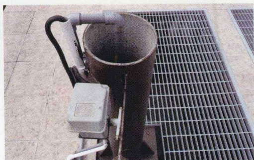
彩图 6-31 第一期 PAC 原液投加,对药剂质量、计量设备、控制系统均须很高的要求
