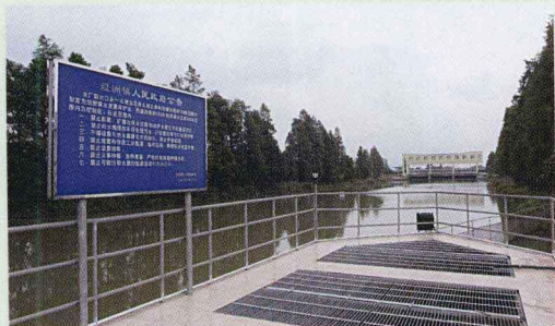
彩图 6-25 为保护水源,镇政府树立水源保护禁止事项标牌。取水口下游节制闸,有效防止原水污染和抵御咸潮
