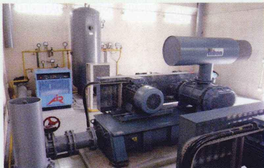
彩图 6-46 气水反冲洗,洗得更干净,是V型滤池有别于传统的其他池型的重要特点
