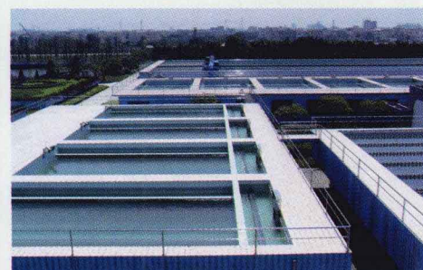
彩图 6-12 净水过滤均采用气-水反冲 V 型滤池,使优质供水有良好的基础
