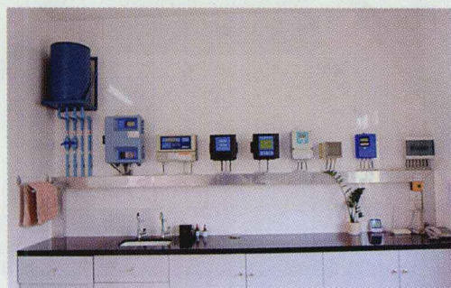
彩图 6-35 出厂水各类在线仪表:余氯、浊度、pH、电导、流量仪表,实时掌握水质与水量
