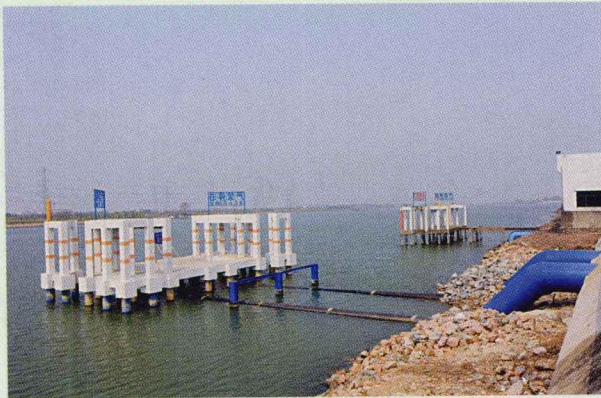
彩图 6-14 在河道主流一侧,B 厂将取水口向江心推移 35m,可有效地改善原水水质
