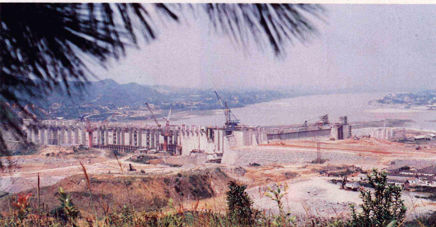
△ 万安水电站施工全景 武警部队水电指挥部供稿
