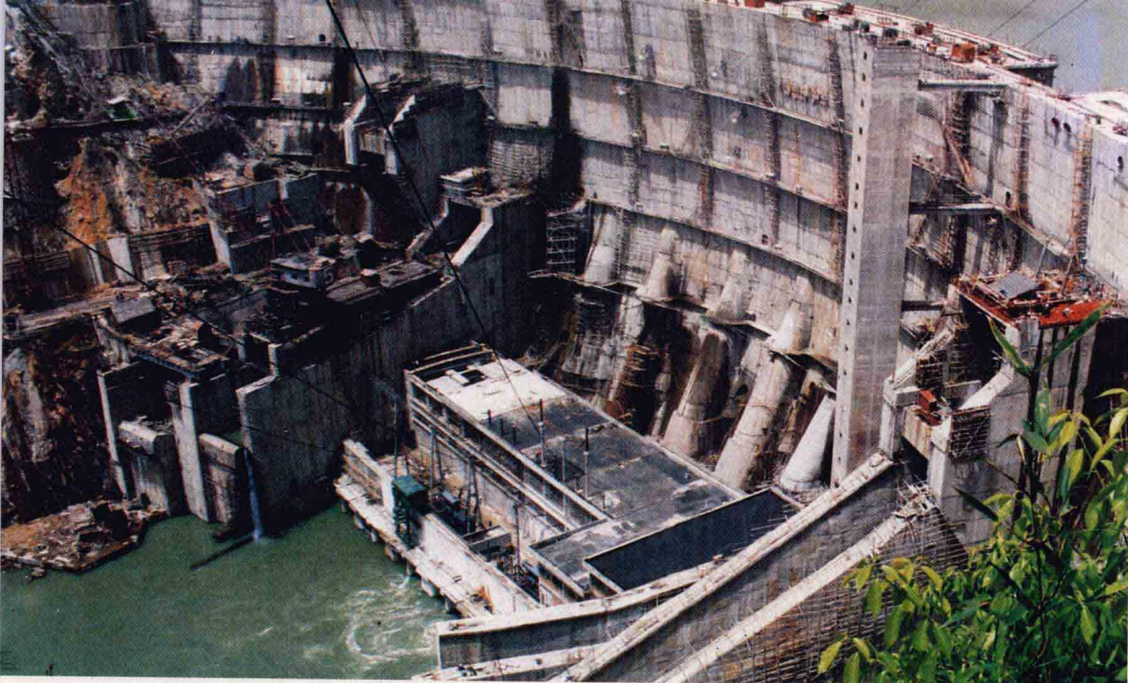
△ 紧水滩水电站大坝全景
