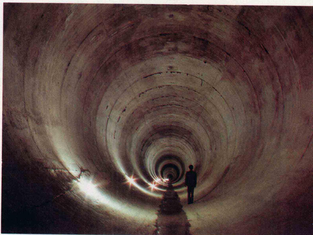
△ 鲁布革水电站引水隧洞 谢玉良摄
