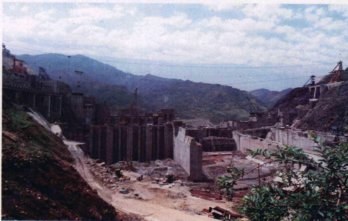
▷ 安康水电站大 坝施工
