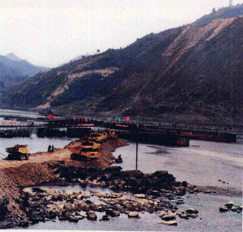
△ 五强溪水电站右岸一期围堰截流 聂策明摄
