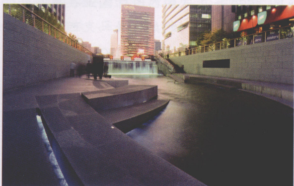
图 1-5 岩石阶梯构成亲水平台
