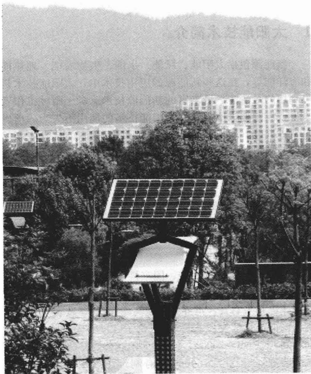
图 3 太阳能技术在园林绿地中的应用——景观照明灯
