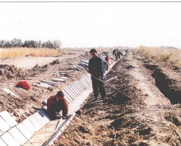
90年代始铺设砗板防渗渠
