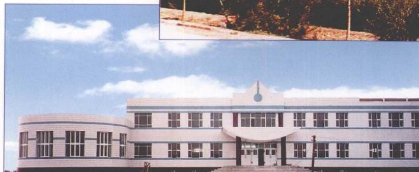
318 省道 11 公里处 新团部机关办公楼落成
