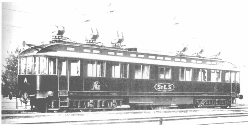
1903年德国AEG公司三相交流电车创造210千米/时最高速度记录
