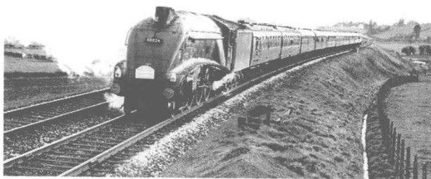
1938年7月3日英国4—6—2轮列流线型“水鸭号”蒸汽机车牵引7辆客车创造203千米/时世界蒸汽机车最高速度记录
