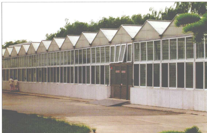
←日本卡乐比（沈阳）食品有限公司马铃薯脱毒小薯繁育连栋温室，占地面积2800m 2 ，采用Venlo型轻钢结构，顶部采用双层中空阳光板覆盖，四周采用双层中空玻璃覆盖，温室内部设保温遮阳幕，可以满足春秋两季进行马铃薯脱毒小薯繁育的需求。
