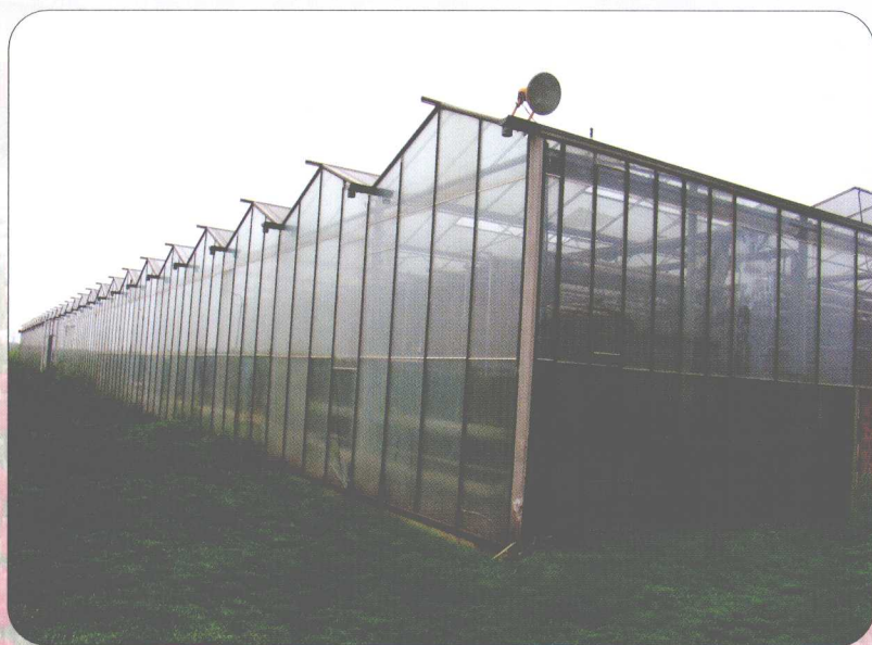
←原辽宁省花卉中心连栋温室，占地面积1公顷，于1995年投资建设，为沈阳市第一个全套引进的荷兰Venlo型结构大型智能温室。该温室为双屋脊结构，内设保温遮阳幕，温室四周和屋顶覆盖材料均为单层4mm浮法玻璃。温室的冬季保温性能和夏季降温性能较差，年原煤消耗量达2300多吨，运行成本较高。后改造增加风机和湿帘降温系统。
