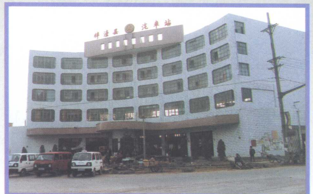
县客运中心汽车站
