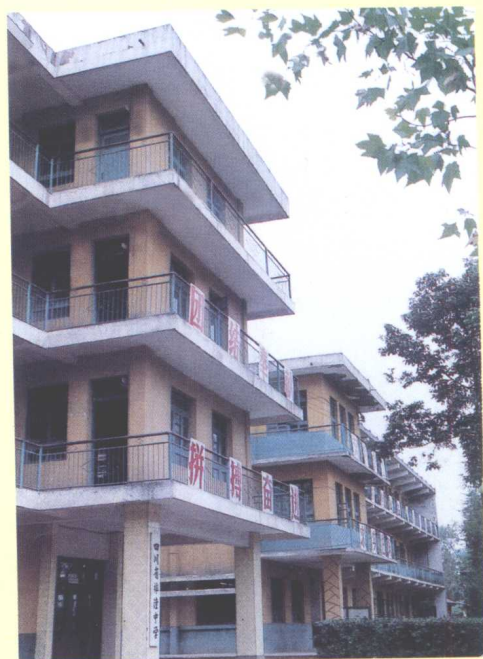
梓潼中学教学大楼
