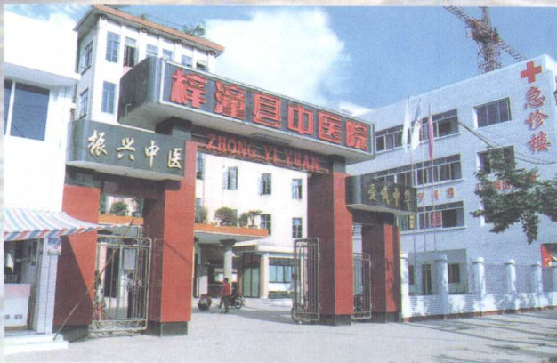
县中医院门诊大楼
