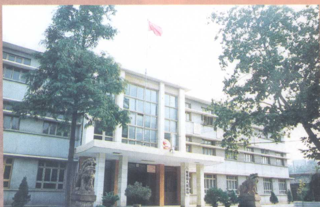
梓潼县人民政府办公大楼
