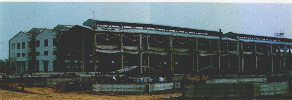
9 正在建设中的工厂西部厂房
