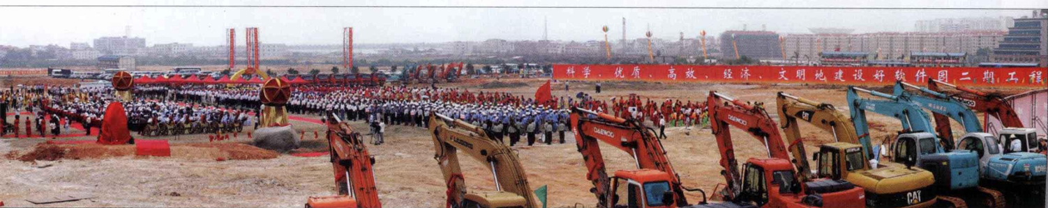
9月6日，厦门软件园二期工程全面开工。图为开工典礼现场。（王协云 摄）
