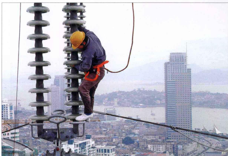
1月17日，厦门电力进岛第三通道第二回线路工程竣工送电。 (郑晓东 摄)
