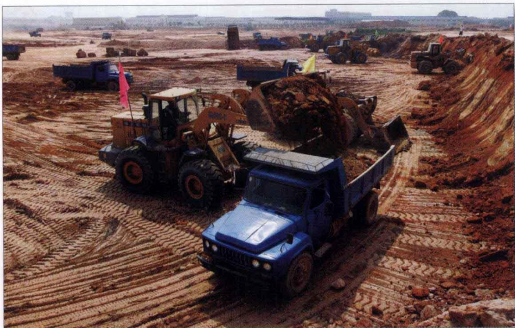
“九八”投洽会期间，总投资规模近20亿元人民币的厦门汽车工业城动工兴建。图为建设工地一角。（林世泽 摄）
