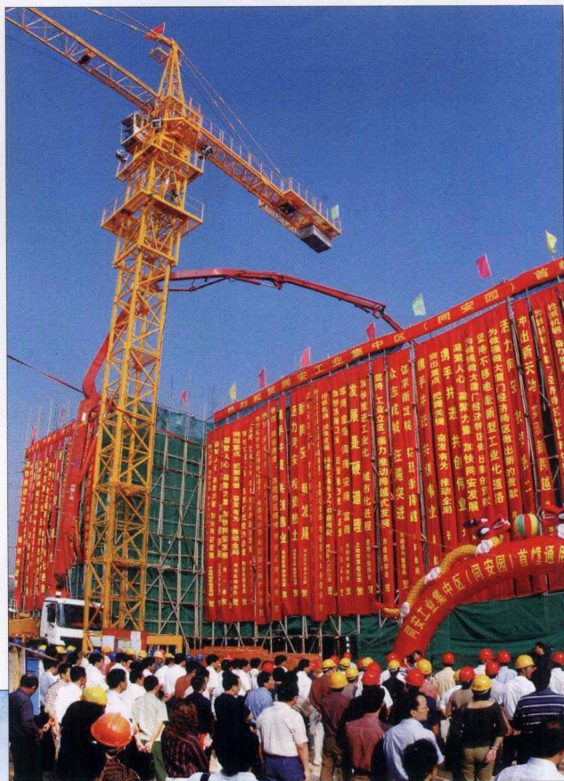
9月15日，全省规模最大的通用厂房建设项目在同安工业集中区开工。经过40天建设，第一幢通用厂房封顶。（陈立新 摄）
