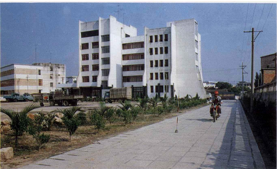
同安县交通局大楼
